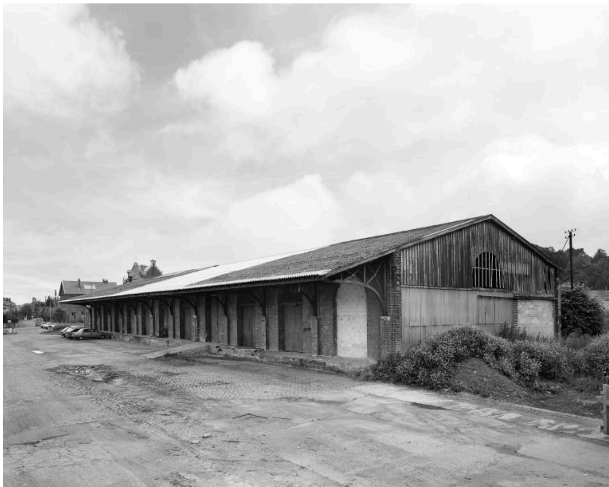
Vue de la halle de chargement.
