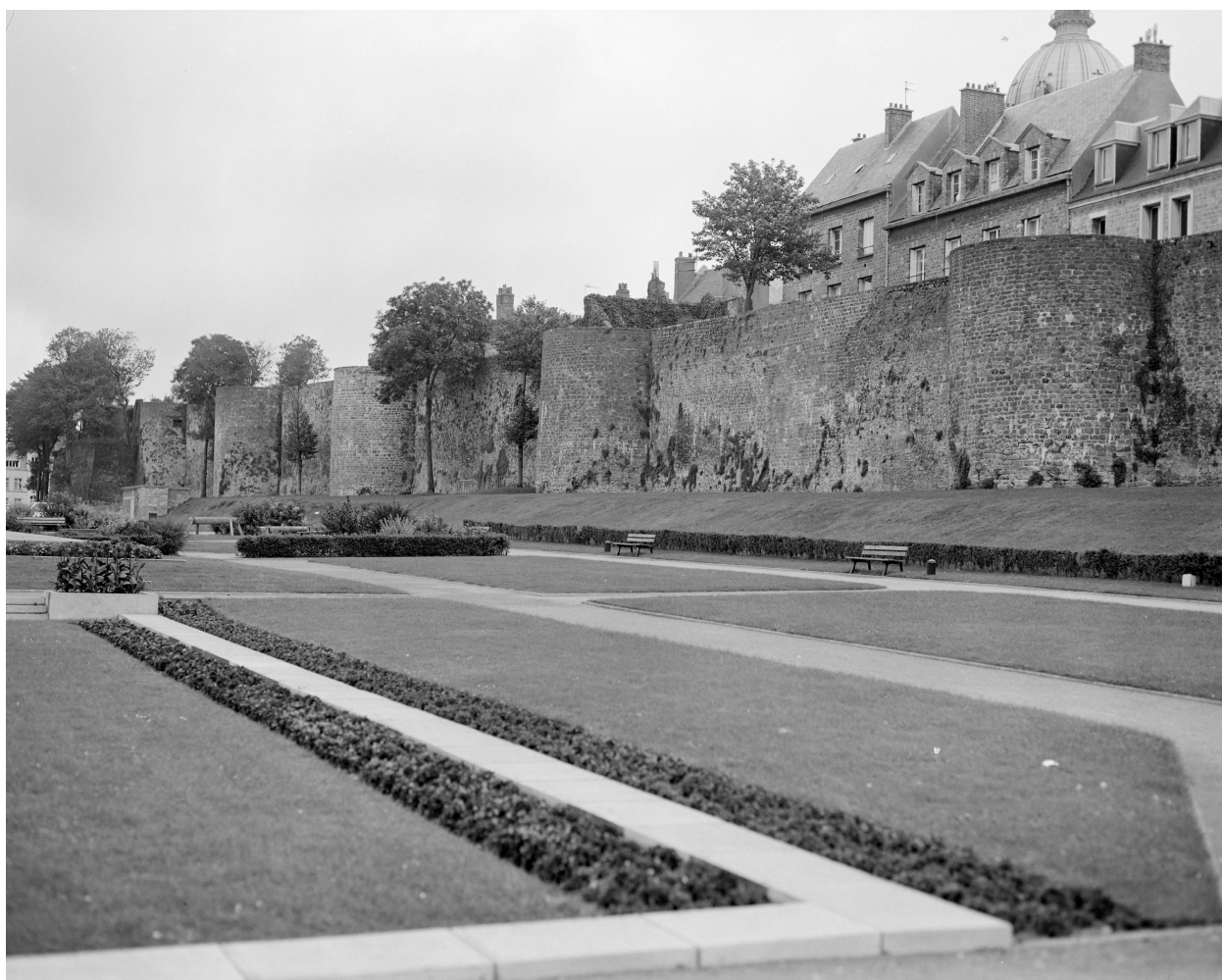
Vue sur boulevard, vue générale côté nord-ouest.
