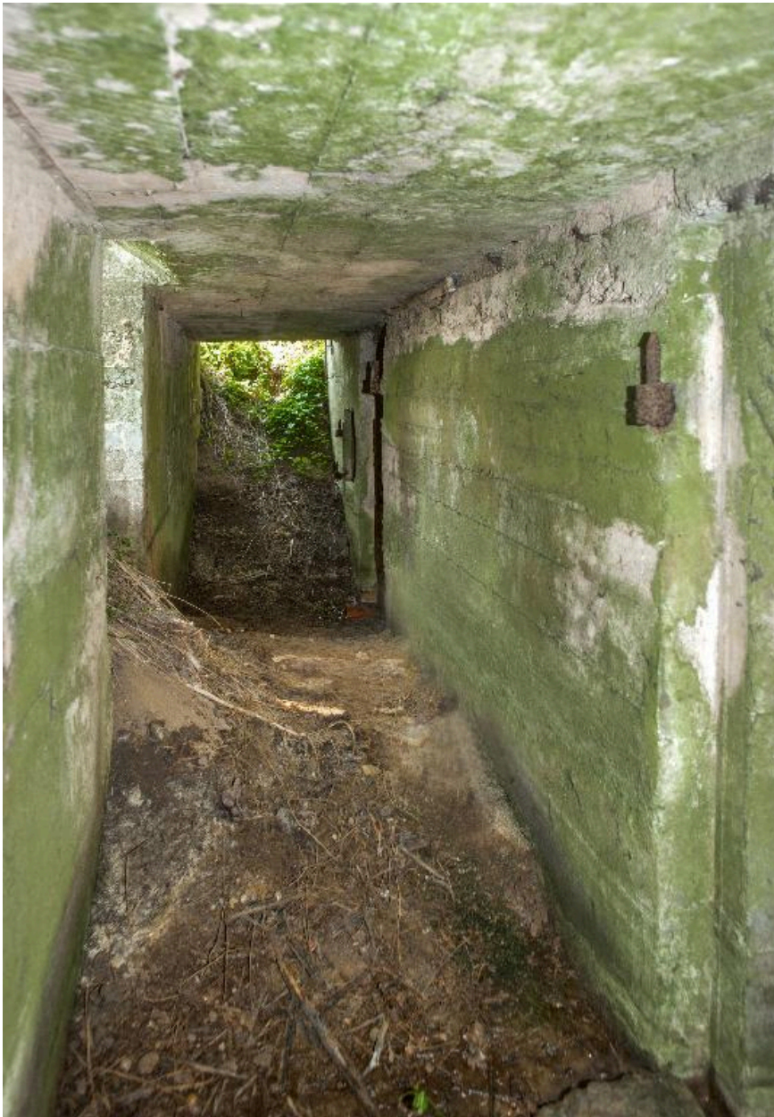
Couloir de distribution, vers le sud
