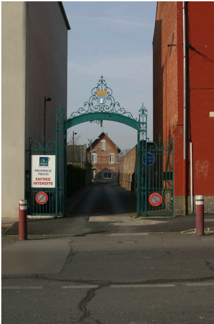
Portail d'entrée de l'usine éleveur. Au fond, la conciergerie et les bureaux.
