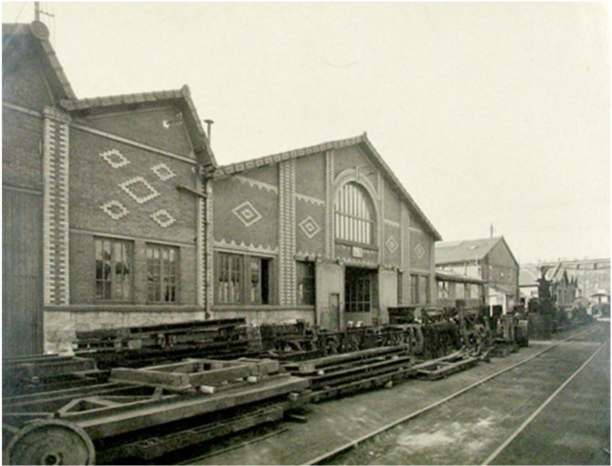
Façades des ateliers Voirin au début de la décennie 1920 avant le programme d'agrandissement des Perret (IFA ; 535 AP 651/7).
