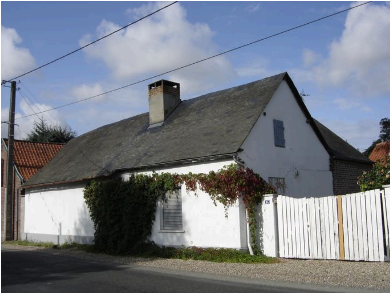
Vue du logis sur rue.
