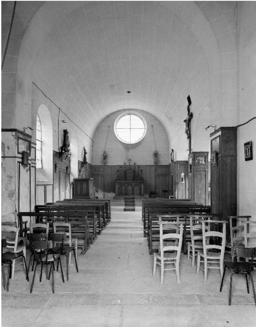
Vue intérieure de l'église, depuis l'entrée vers le chœur.
