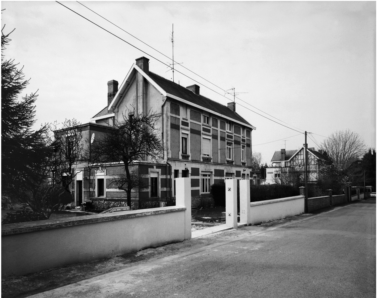
Vue générale de l'alignement.
