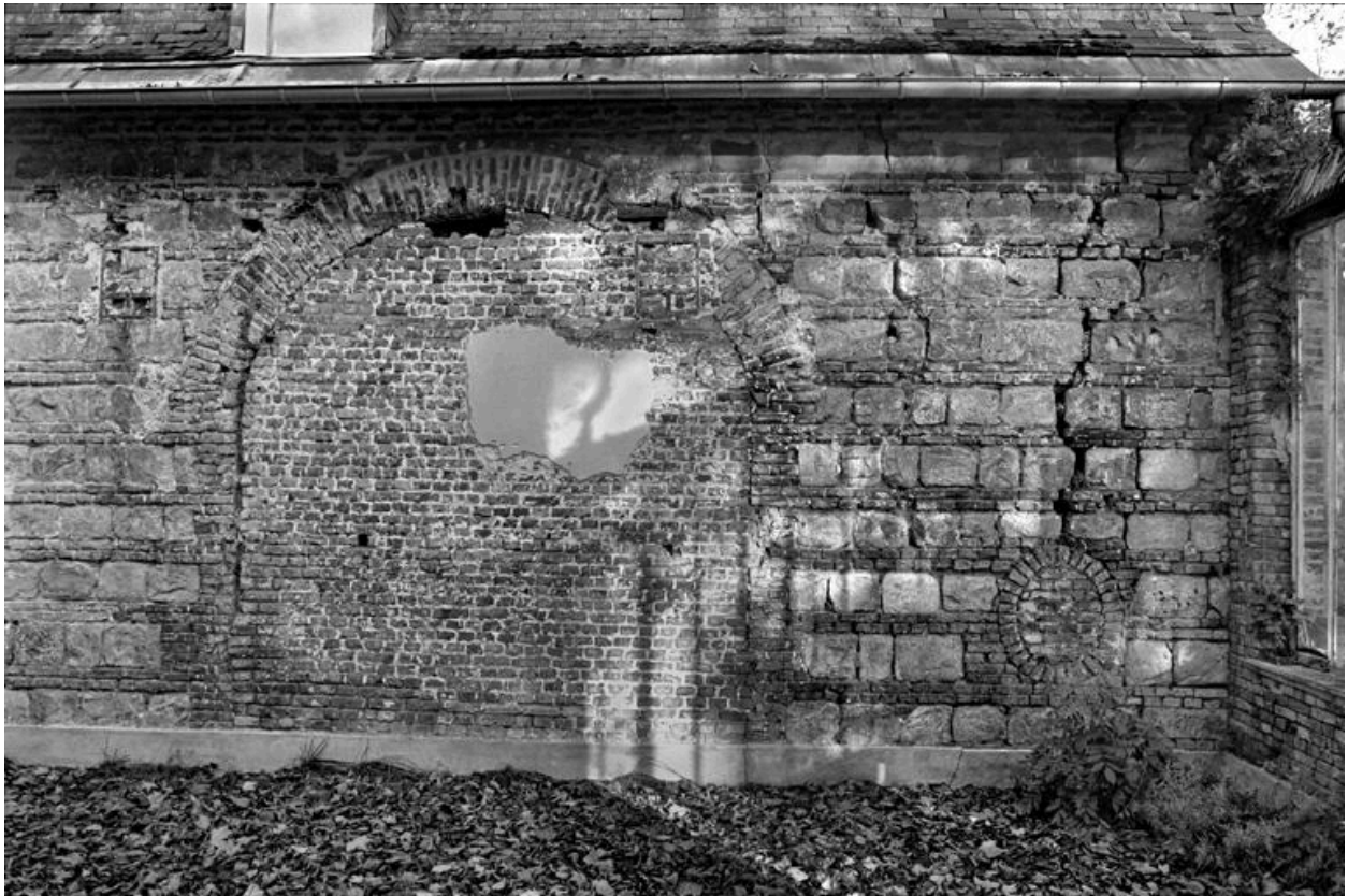
Vue de la porte cochère murée du pavillon oriental.
