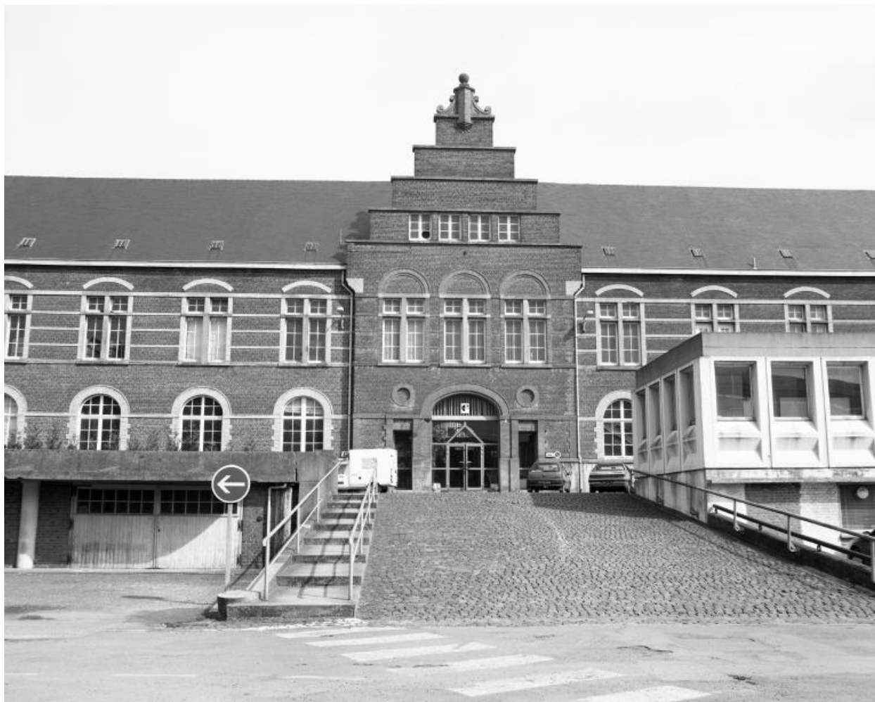
Élévation postérieure des grands bureaux. L'entrée (façade-pignon).
