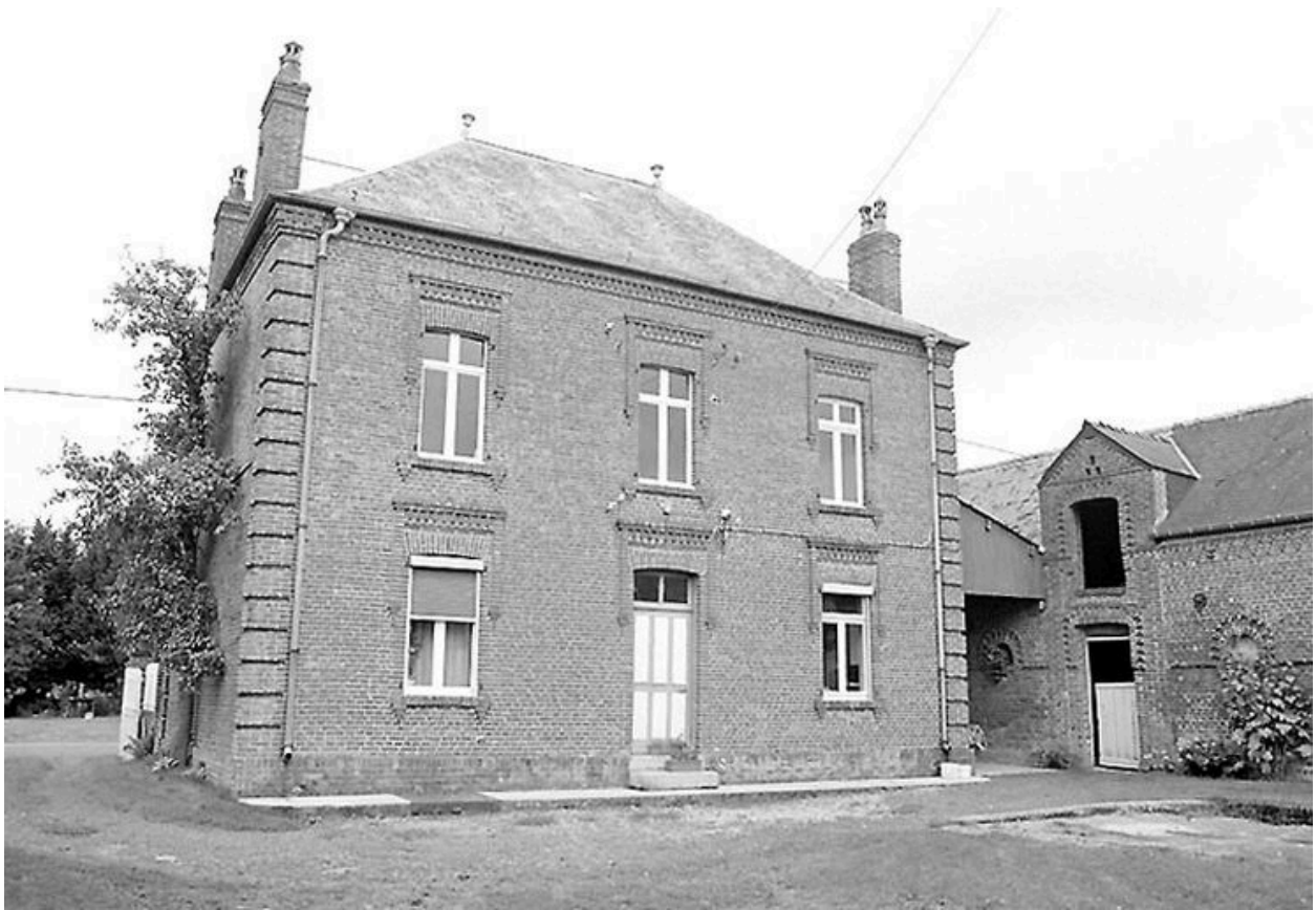
Vue postérieure du logis.
