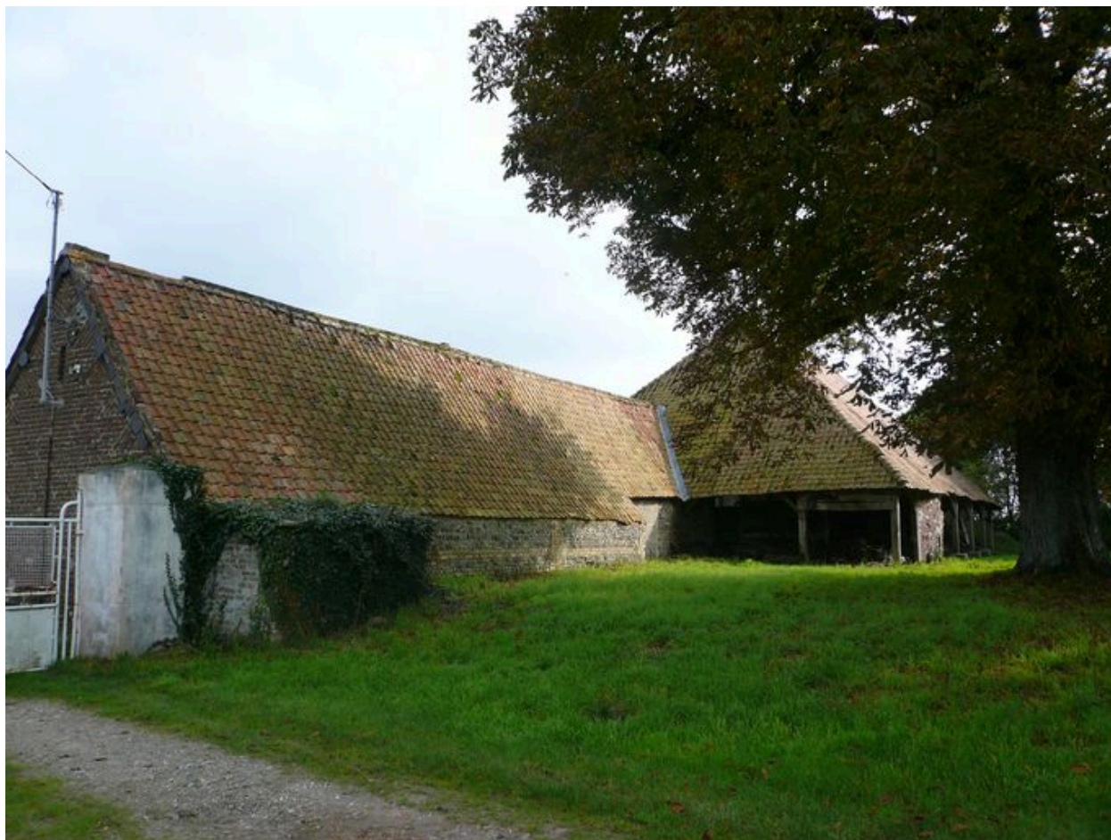
Vue postérieure des étables et de la charretterie.
