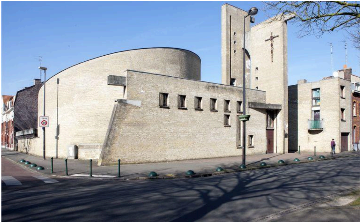
Élévation antérieure de trois quart gauche.
