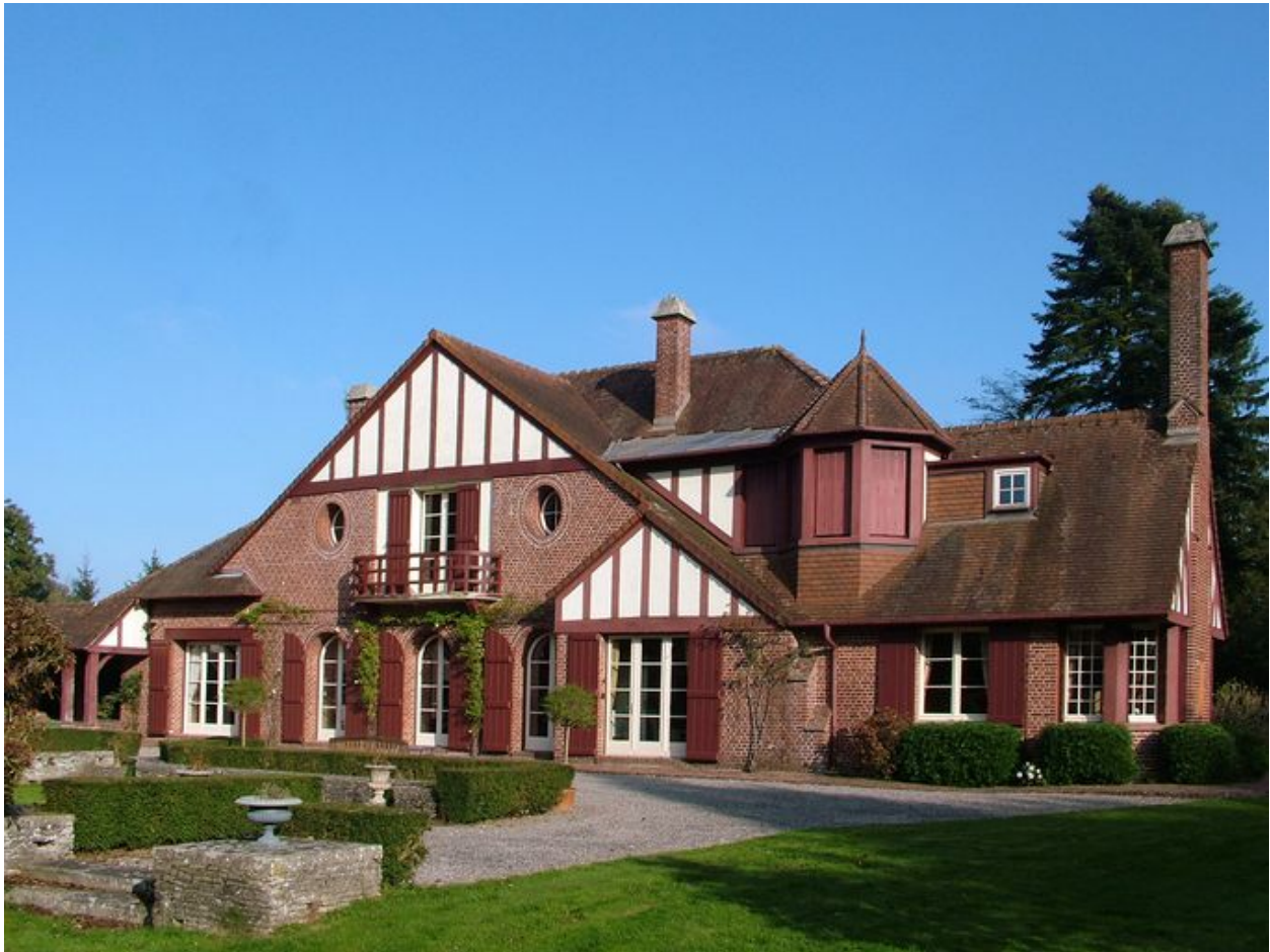
Façade postérieure du logis, de trois-quarts.
