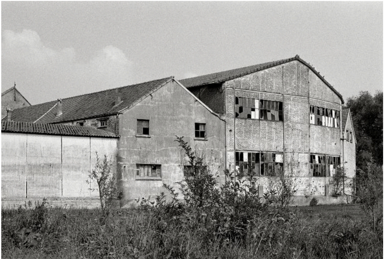
Ateliers de fabrication, élévations postérieures.
