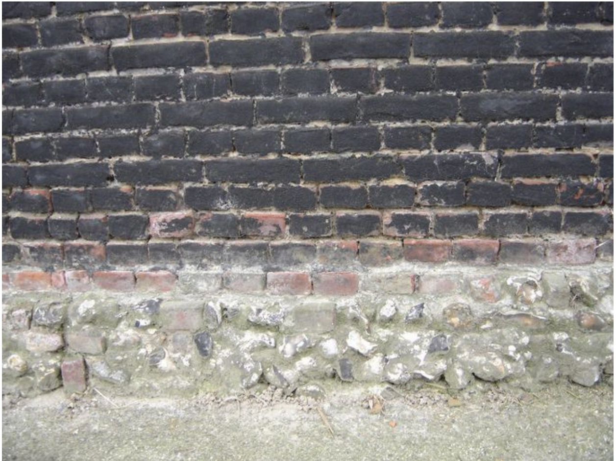
Détail du solin de la grange.
