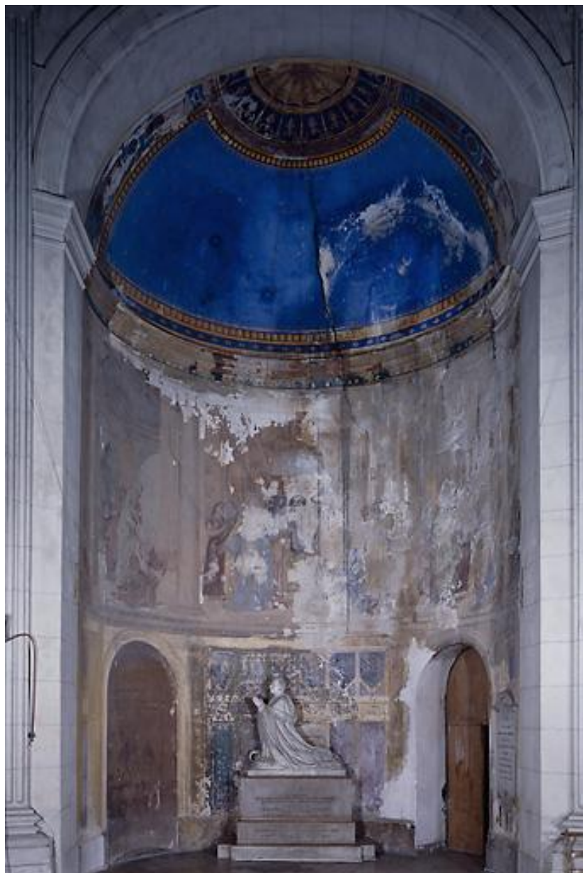
Vue générale, avant restauration.
