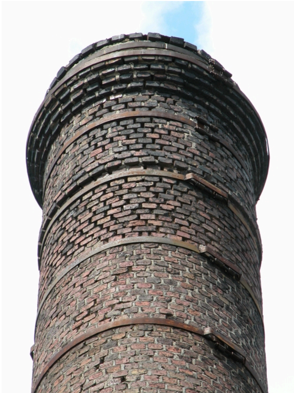
Sommet de la cheminée d'usine.
