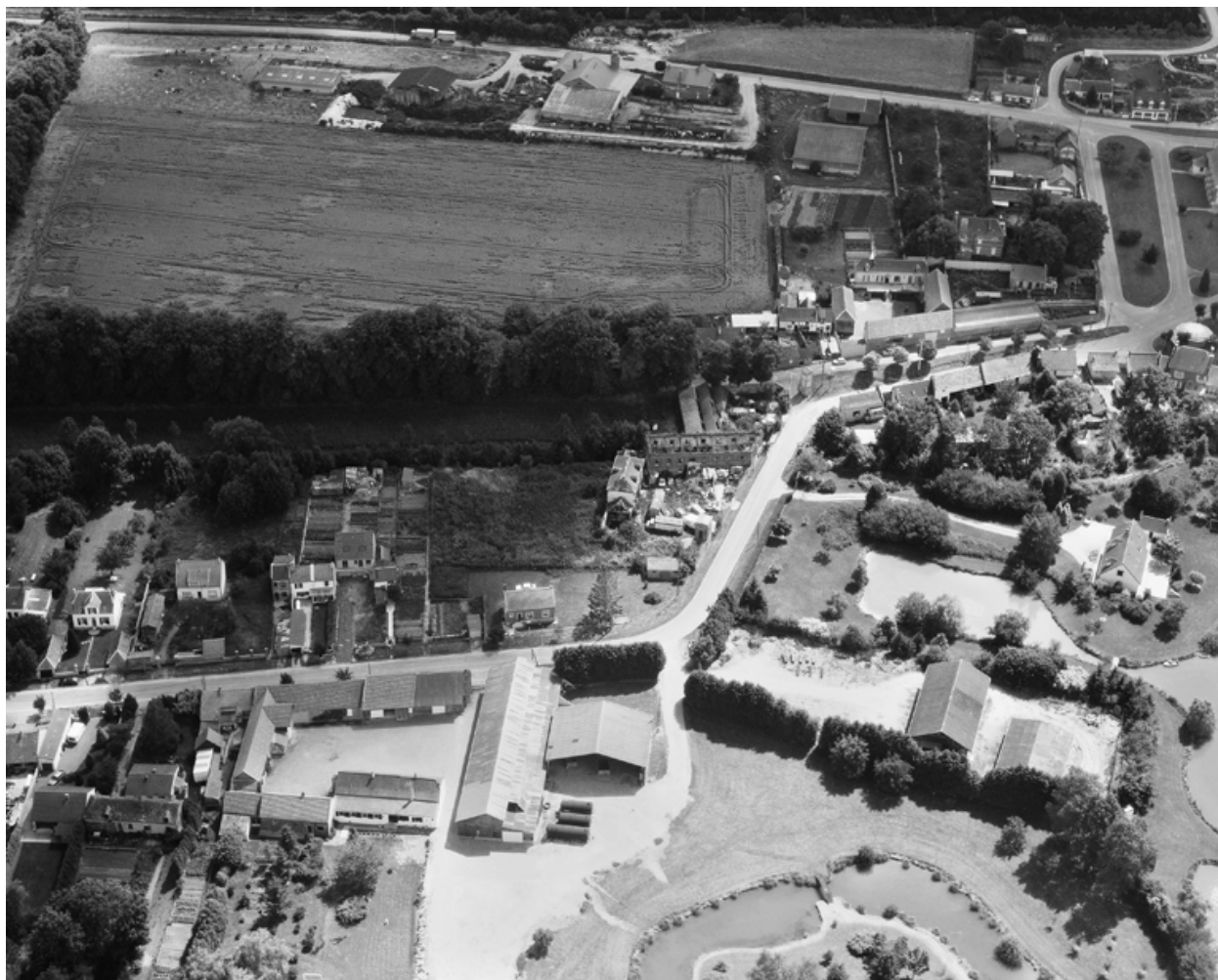
Vue aérienne, flanc ouest.
