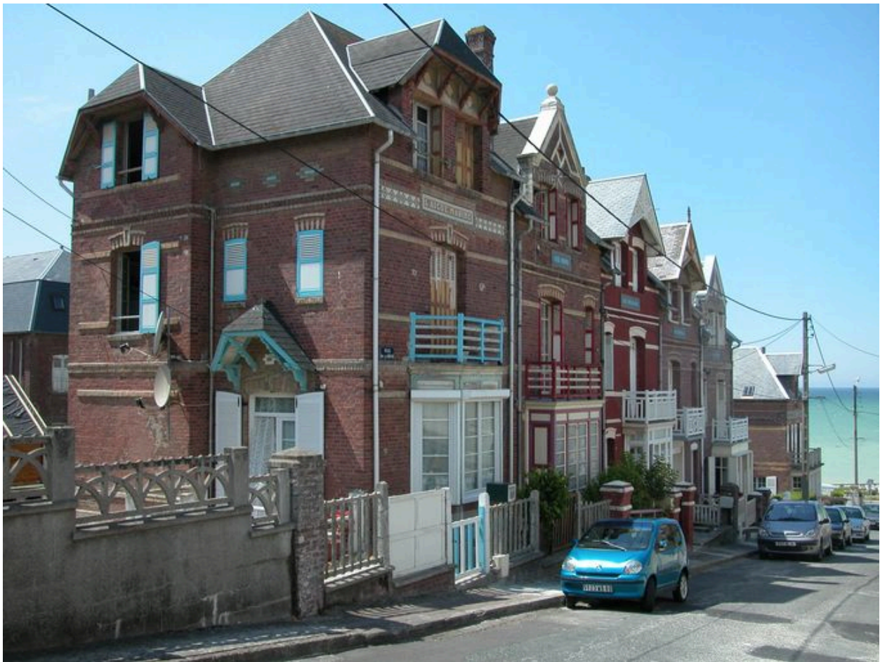
Maisons rue de la Brise.
