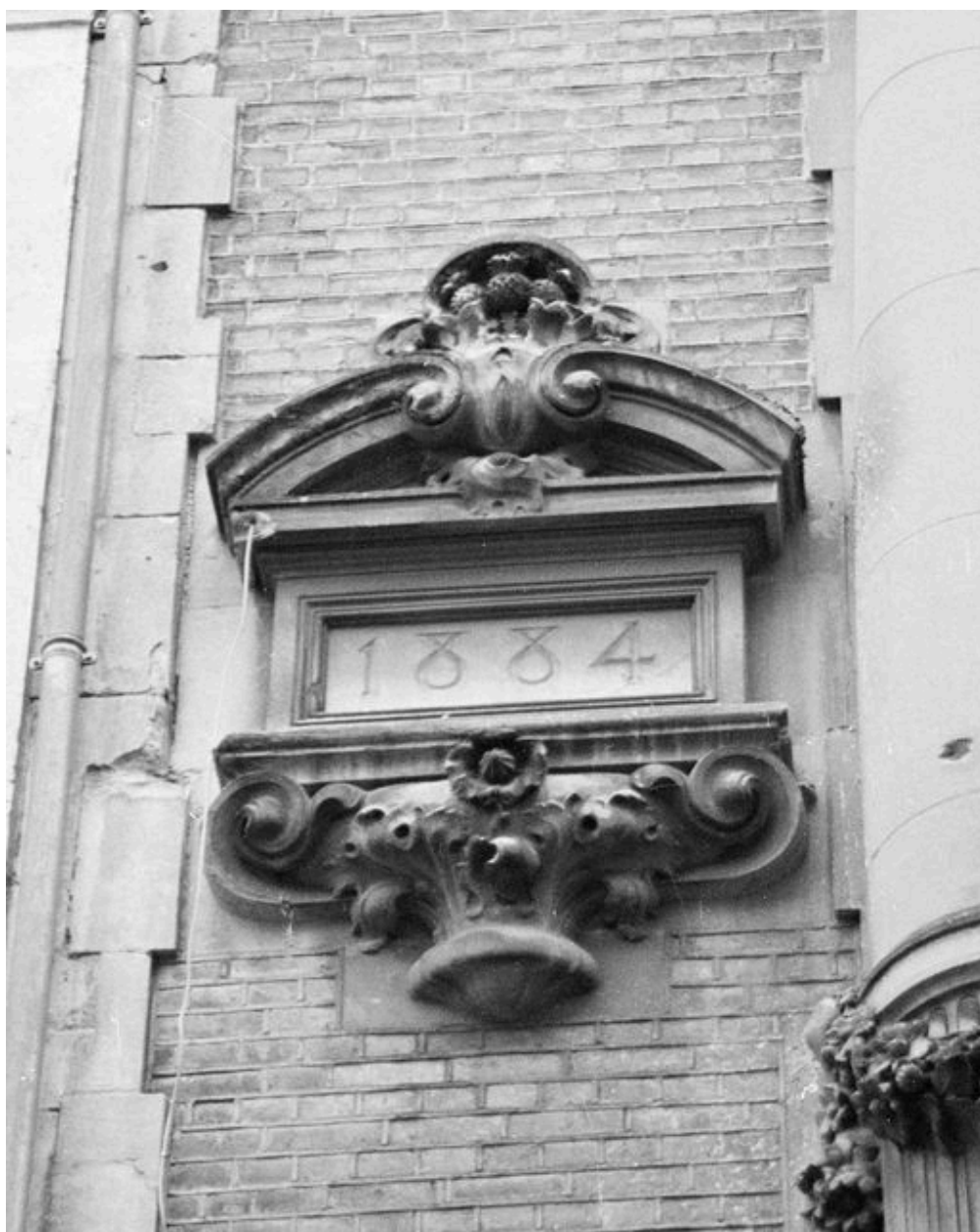
Façade sur rue : détail du cartouche portant la date de 1884.
