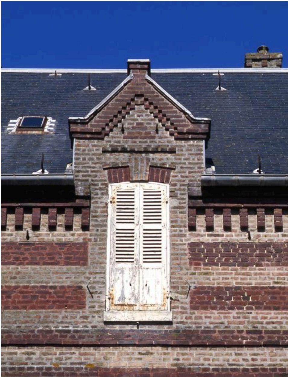
Détail d'une fenêtre de lucarne à fronton-pignon.
