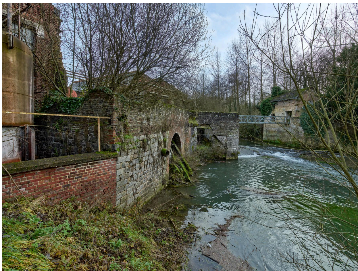
Pont métallique sur l'Authie et coulerie de l'ancien moulin de Rouval.
