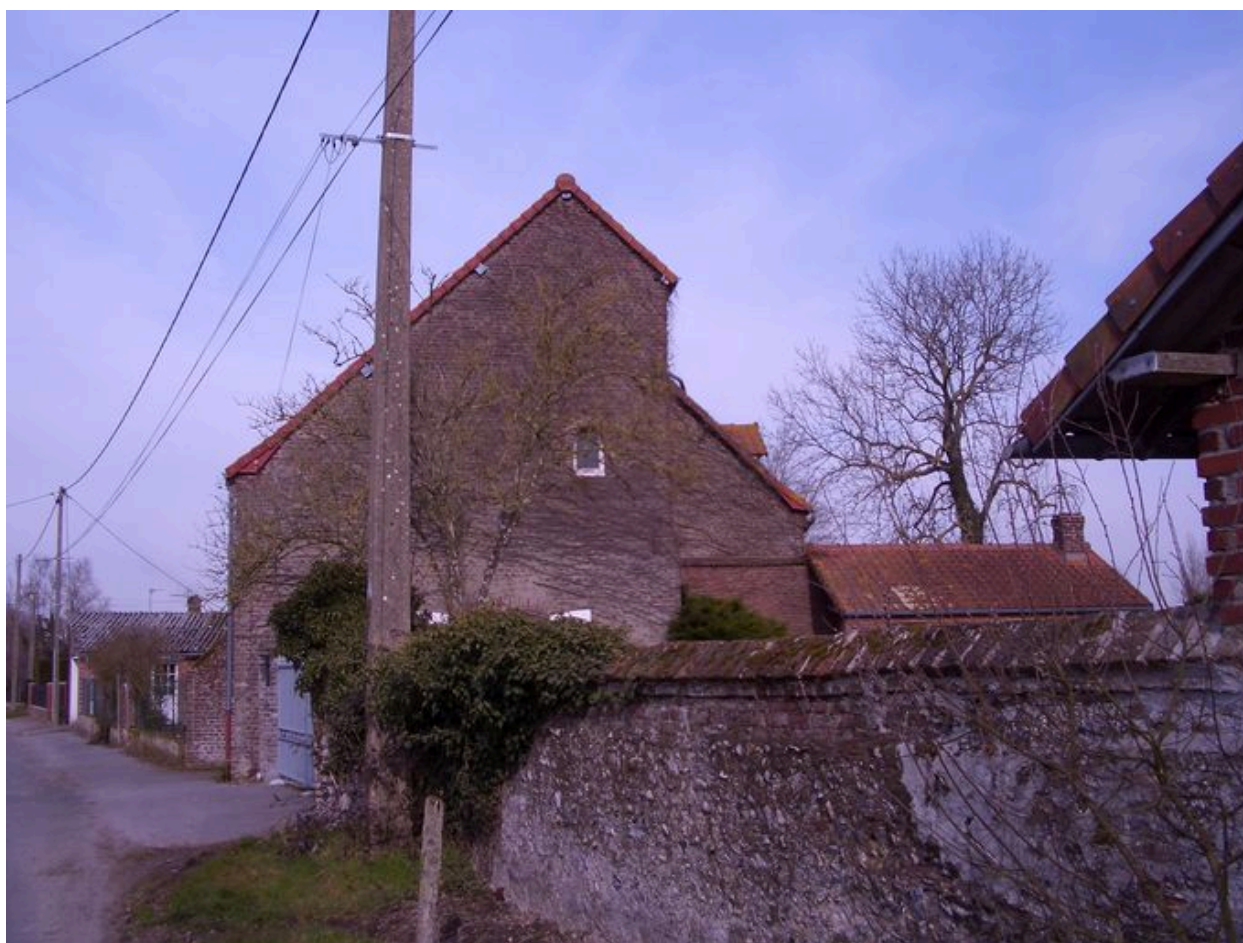
Vue du pignon sud.
