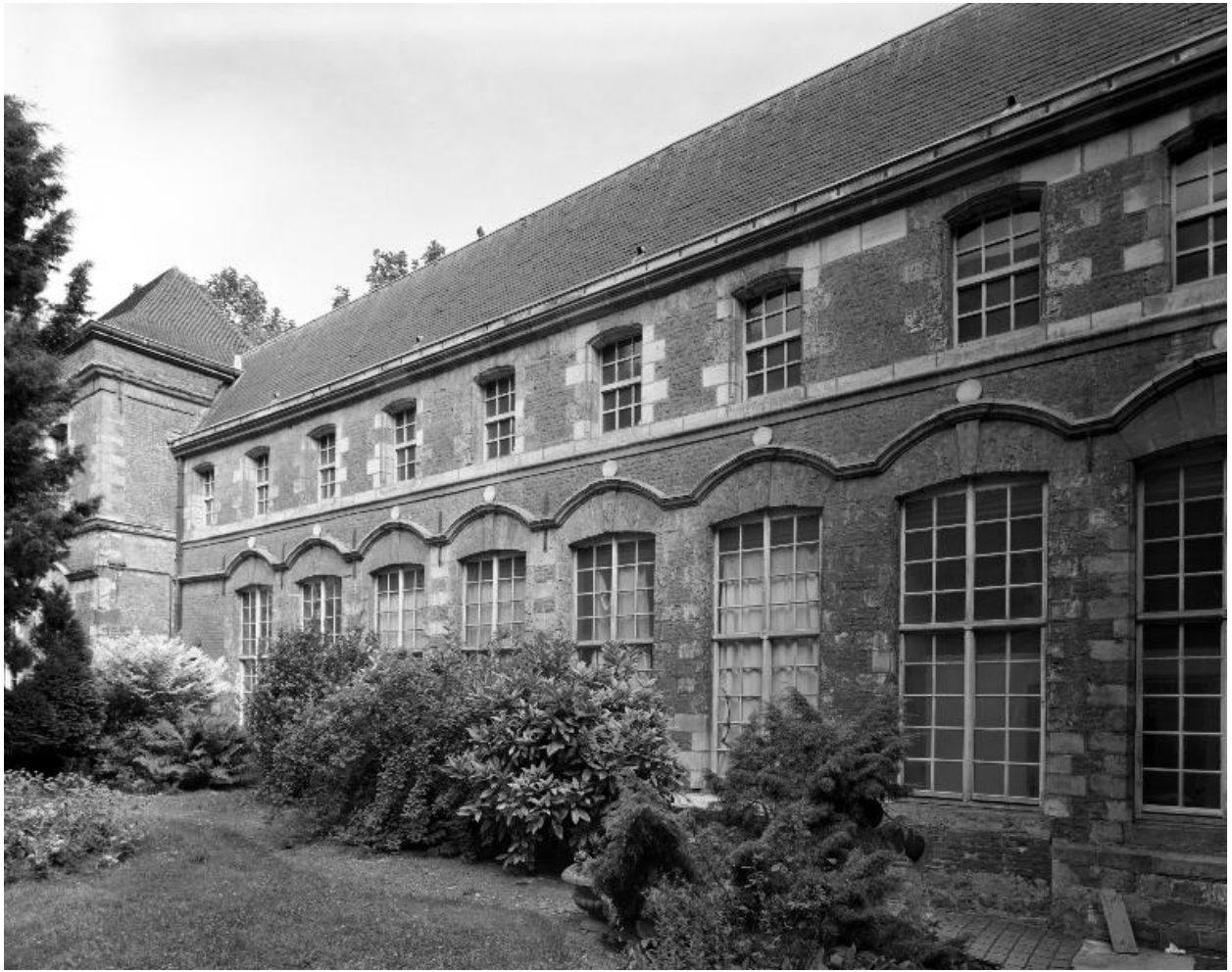
Bâtiment bordant le côté nord de la cour d'honneur, élévation sur la cour.
