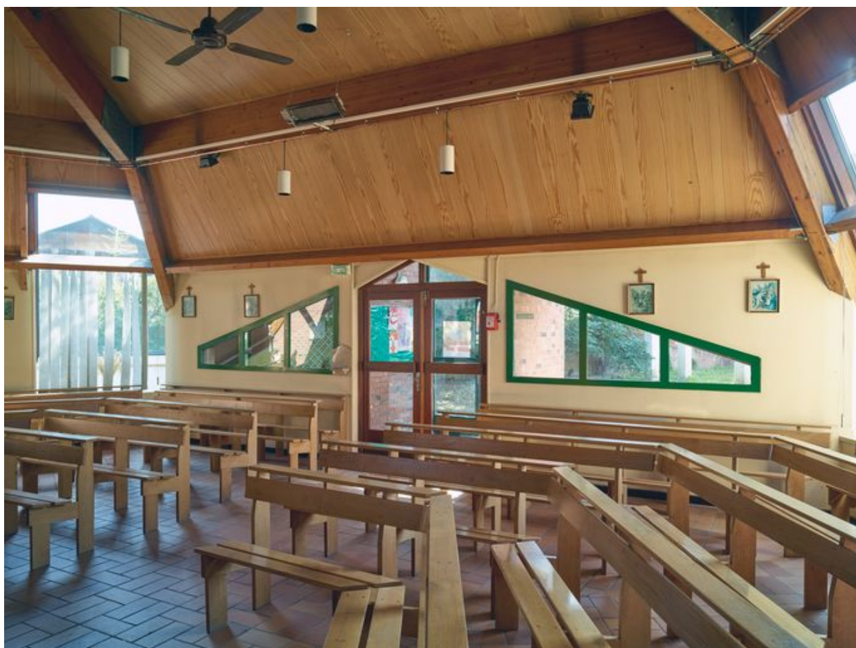
Vue générale de la nef de trois quart depuis le chœur.
