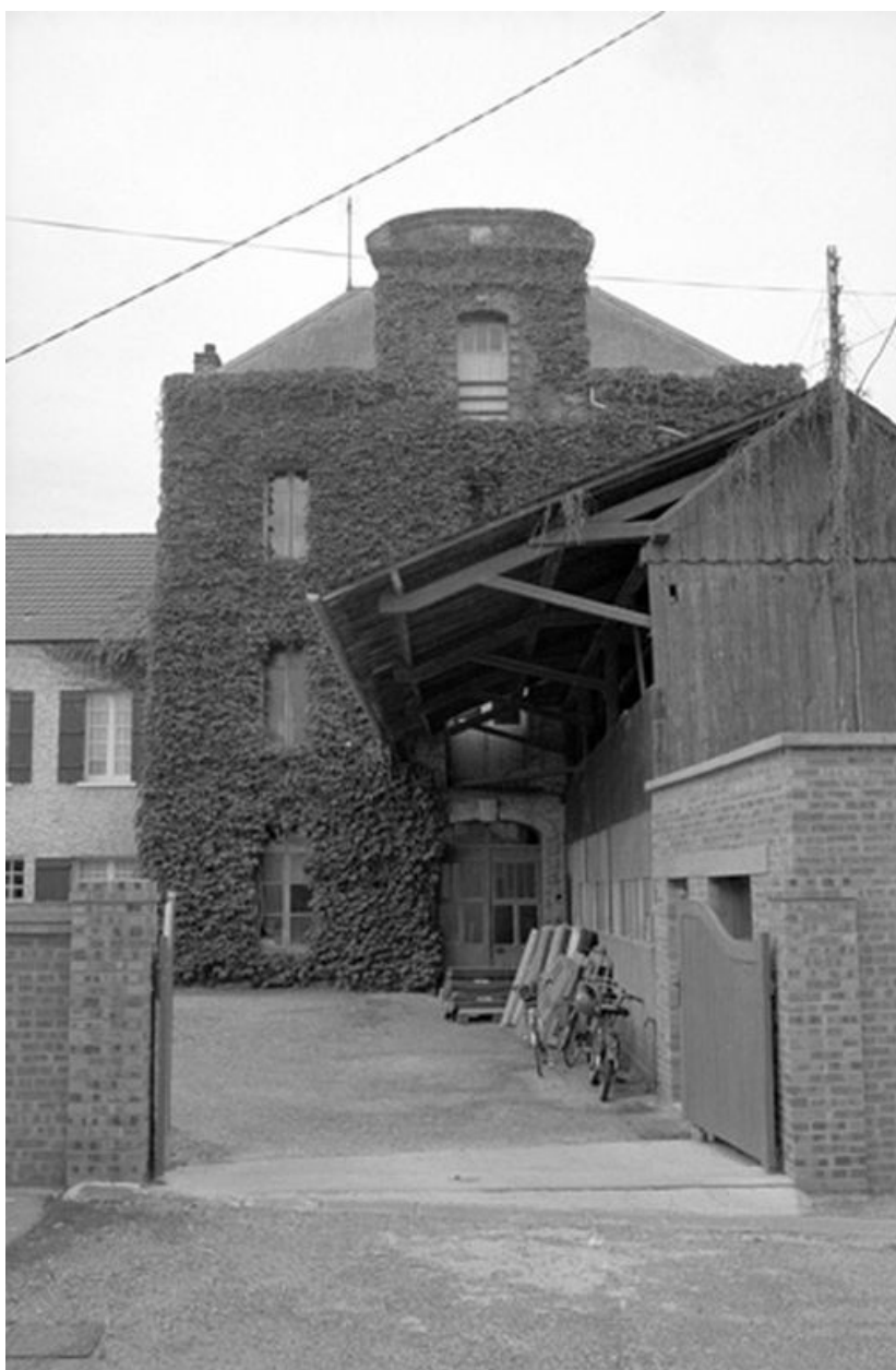
Bâtiment d'eau, élévation antérieure.
