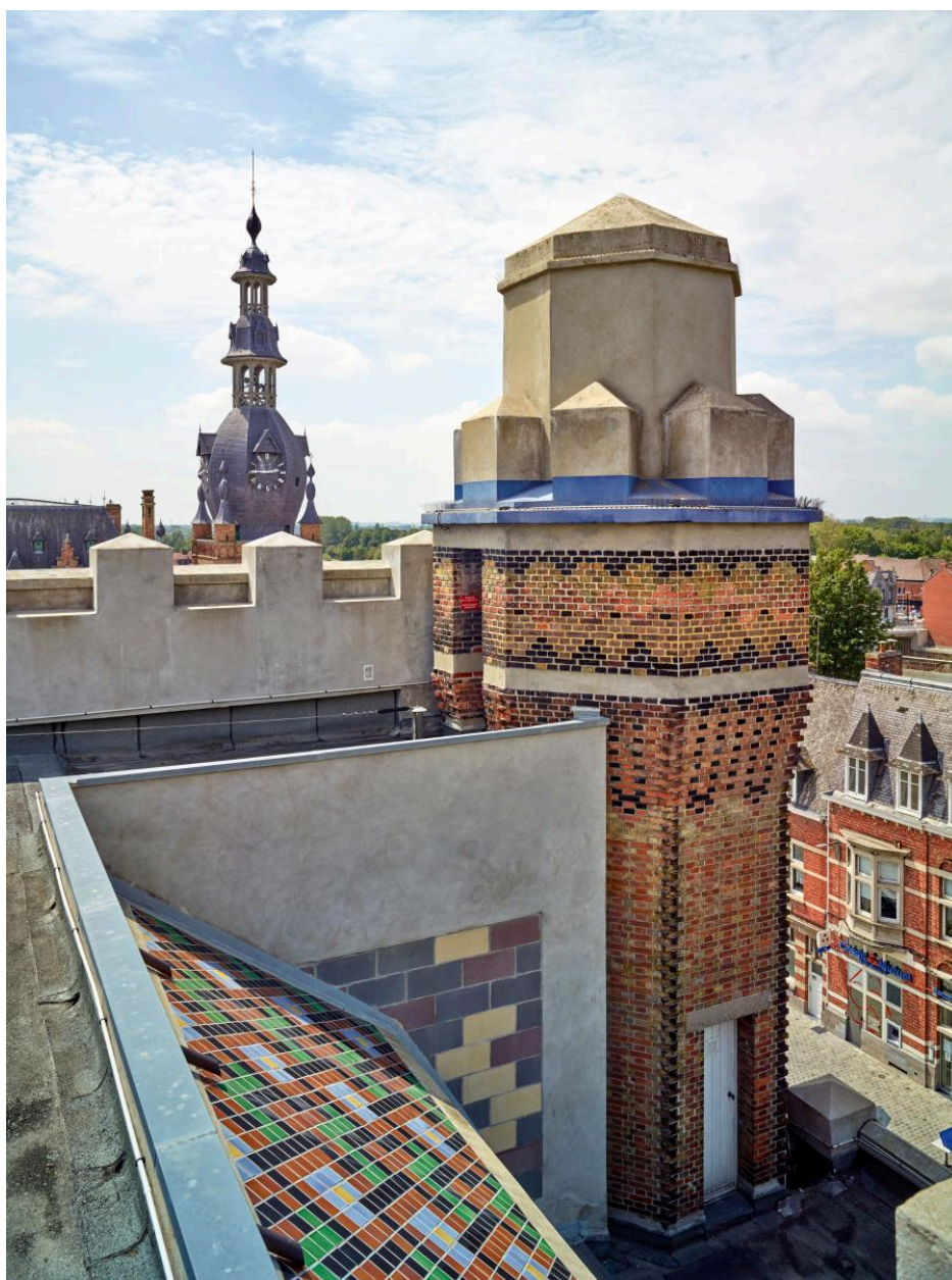
Couronnement de la tourelle d'escalier du côté nord.
