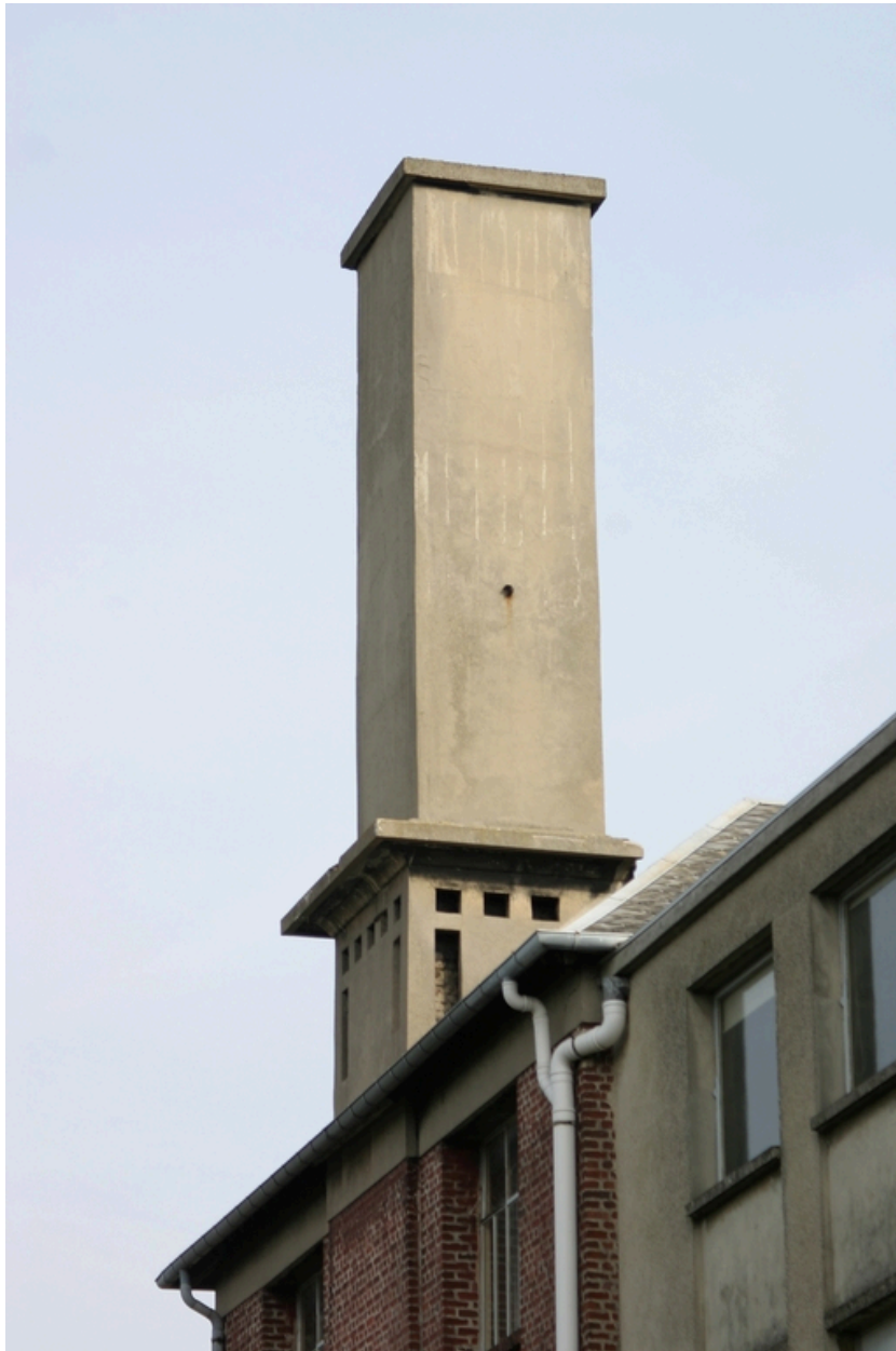
Détail d'une des cheminées surplombant les bureaux.
