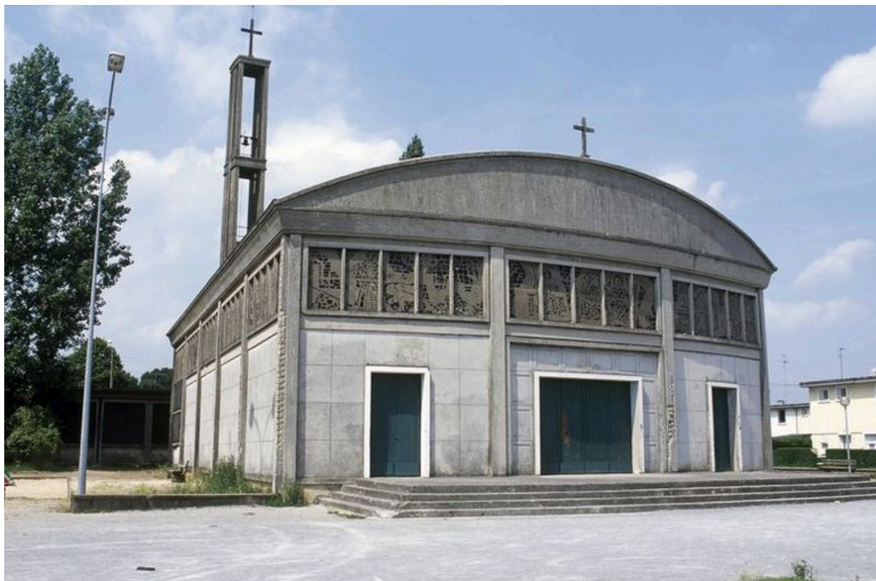
Vue générale des élévations ouest et sud.
