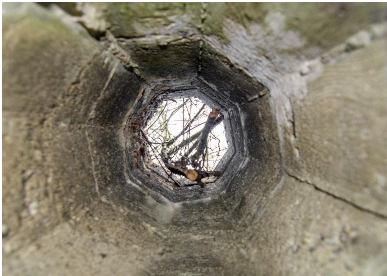
Poste de tir et de surveillance : Vue zénithale de la cheminée périscopique
