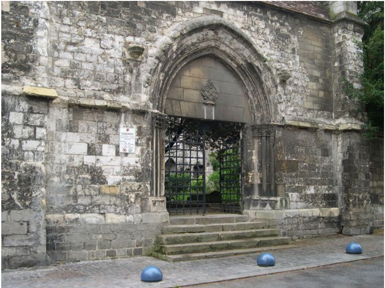
Vestiges de l'ancienne église conventuelle, façade ouest.
