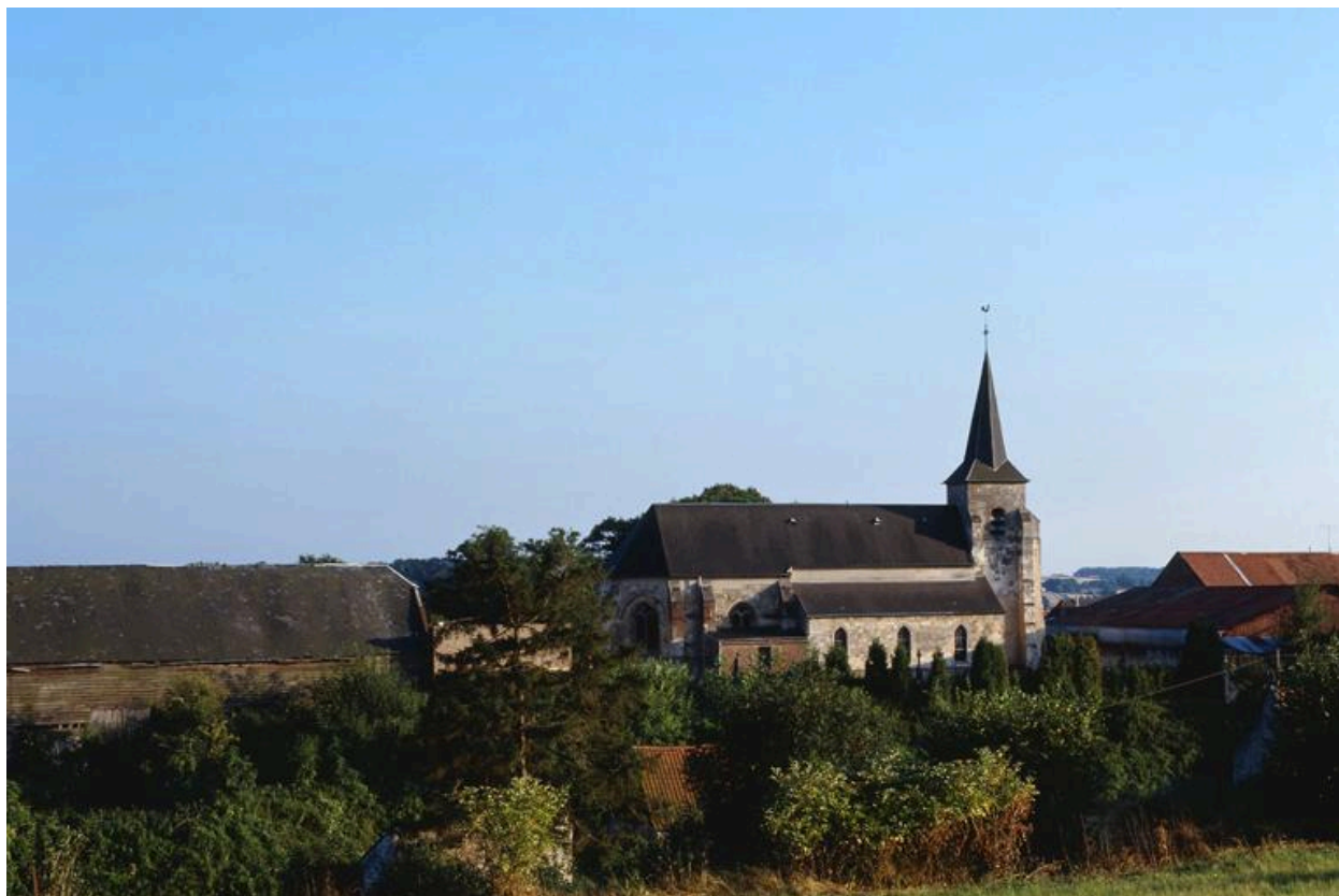
Vue d'ensemble de l'église Saint-Pierre, depuis le nord-est.
