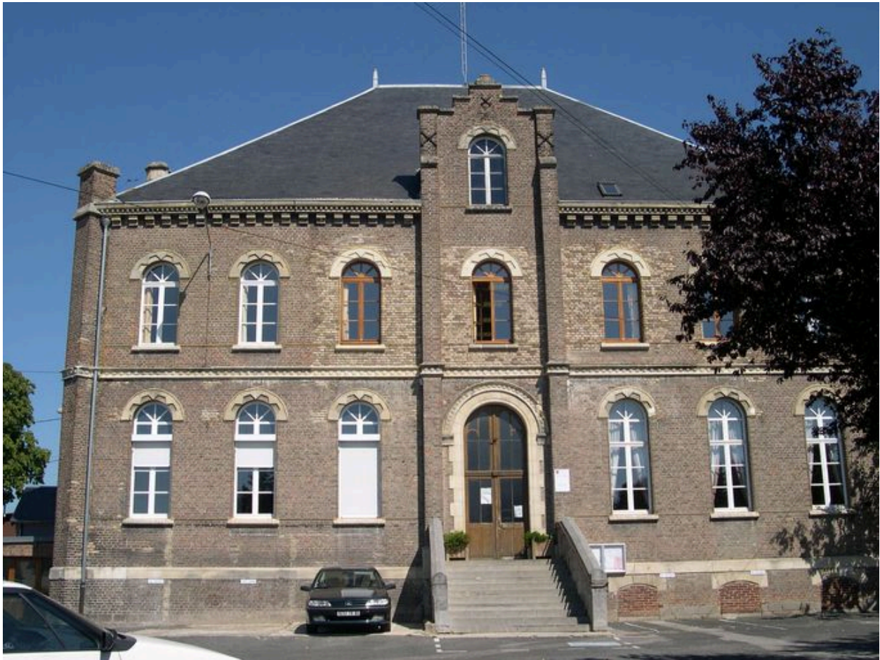
Vue de la façade sud.
