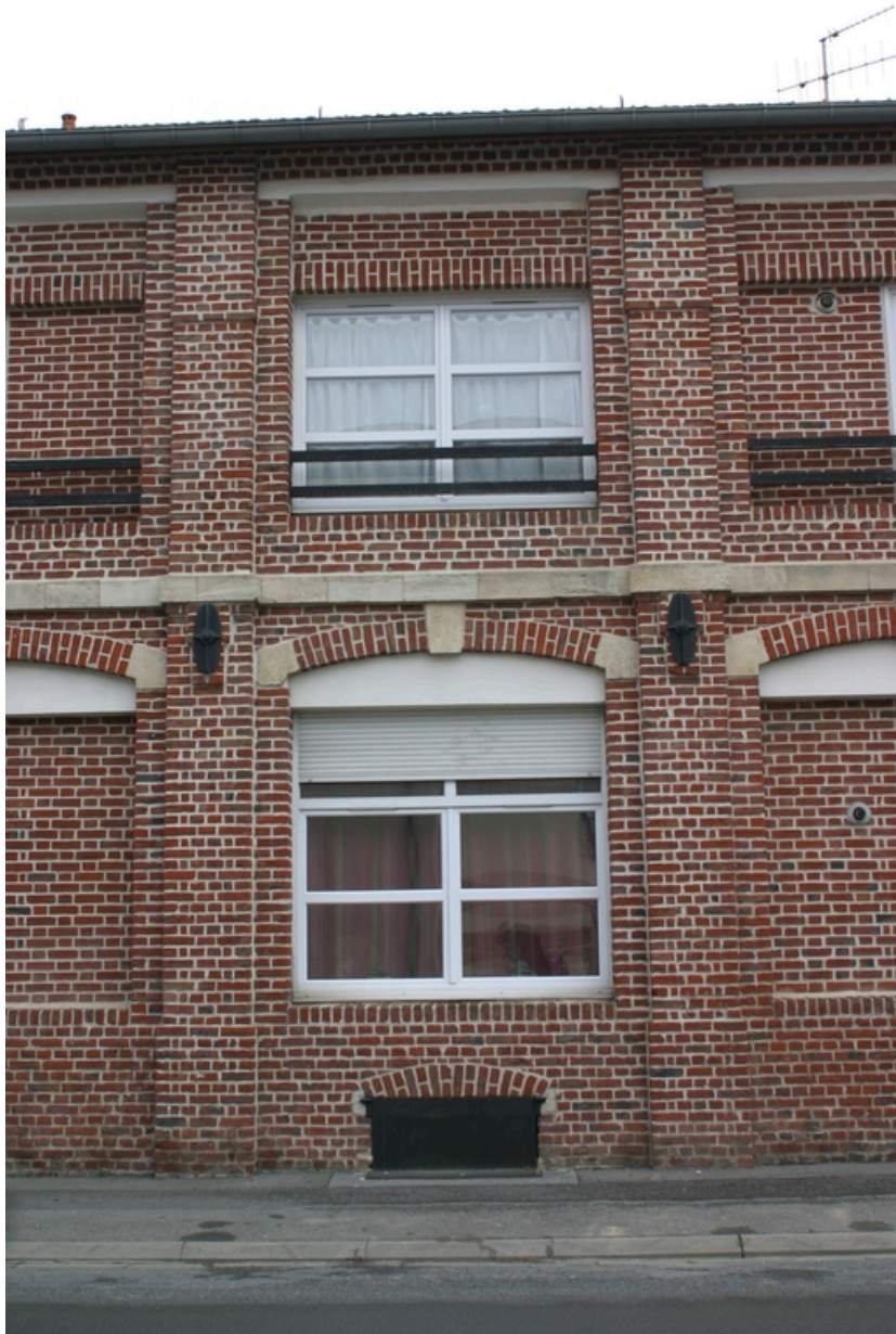
Travée de l'atelier de tulle de la rue de la Chaussée-Romaine.
