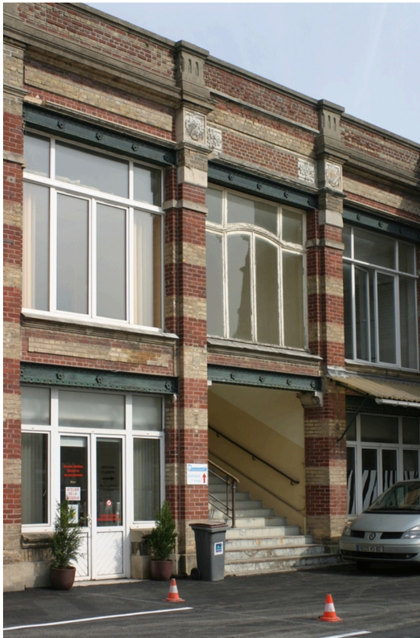
Façade des bureaux construits en 1913.
