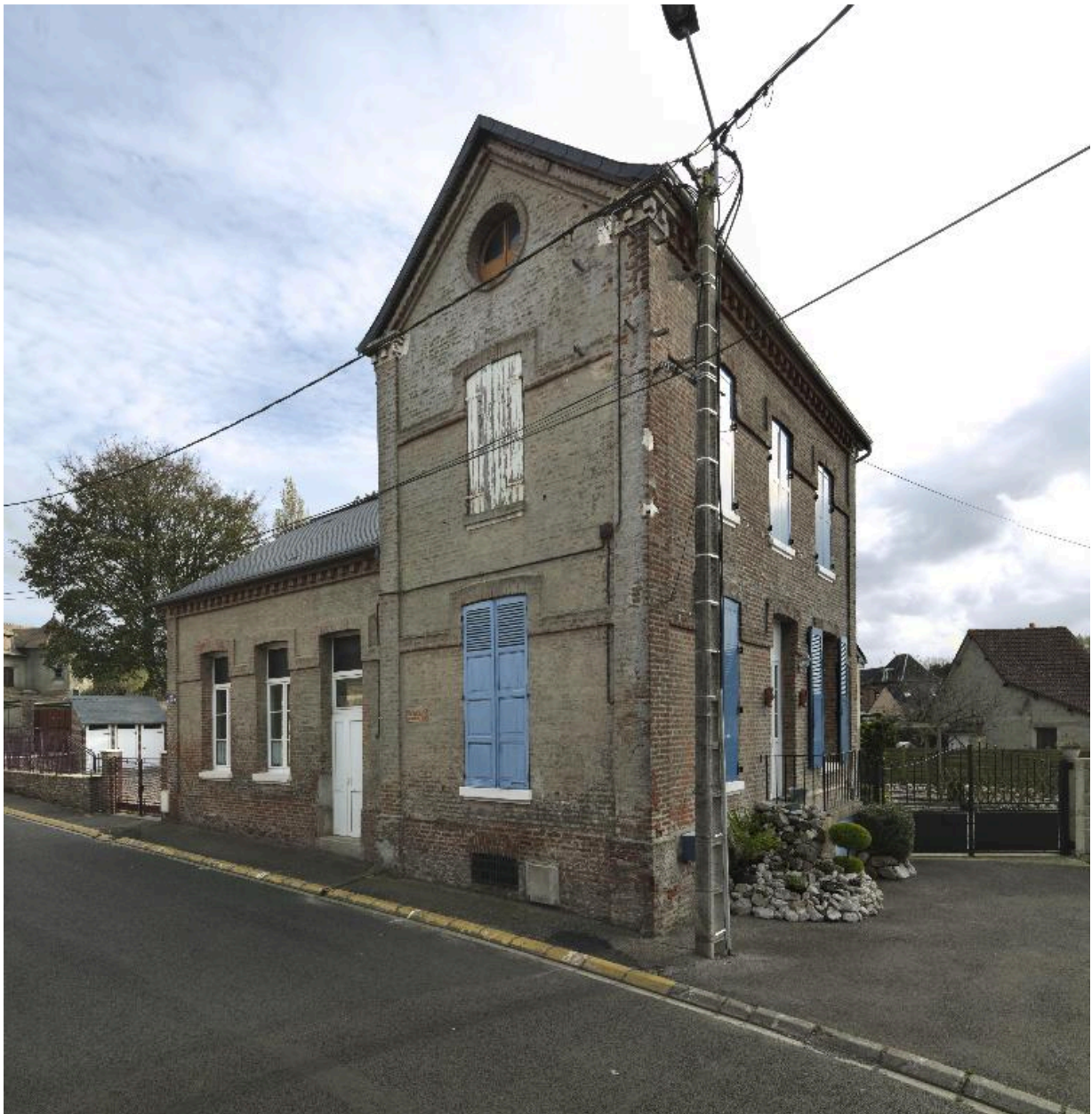
Vue générale depuis la rue des écoliers.
