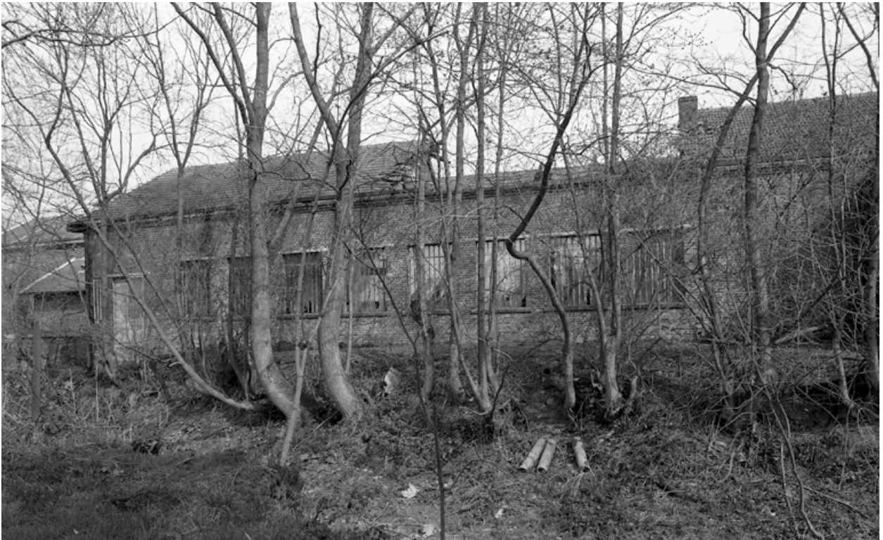
Vue partielle des bâtiments au sud de l'usine.
