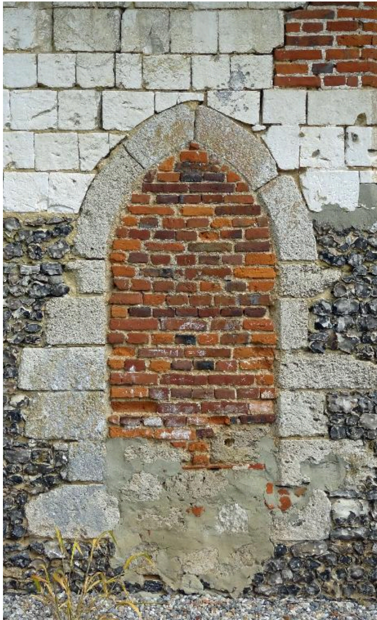
Porte comblée du mur gouttereau sud.
