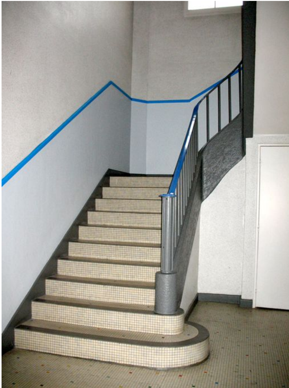
Départ de l'escalier menant aux anciens bureaux.
