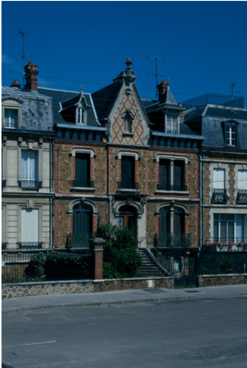
Vue générale depuis la place.
