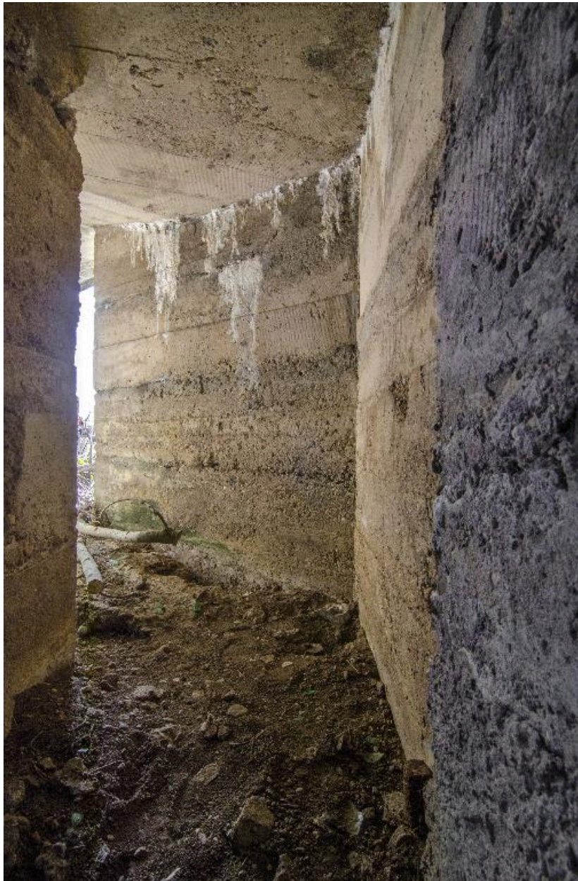
Couloir en chicane. Sortie sud
