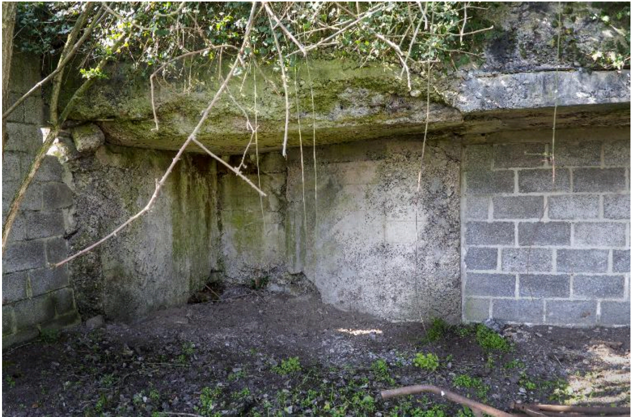
Elévation sud-est, détail
