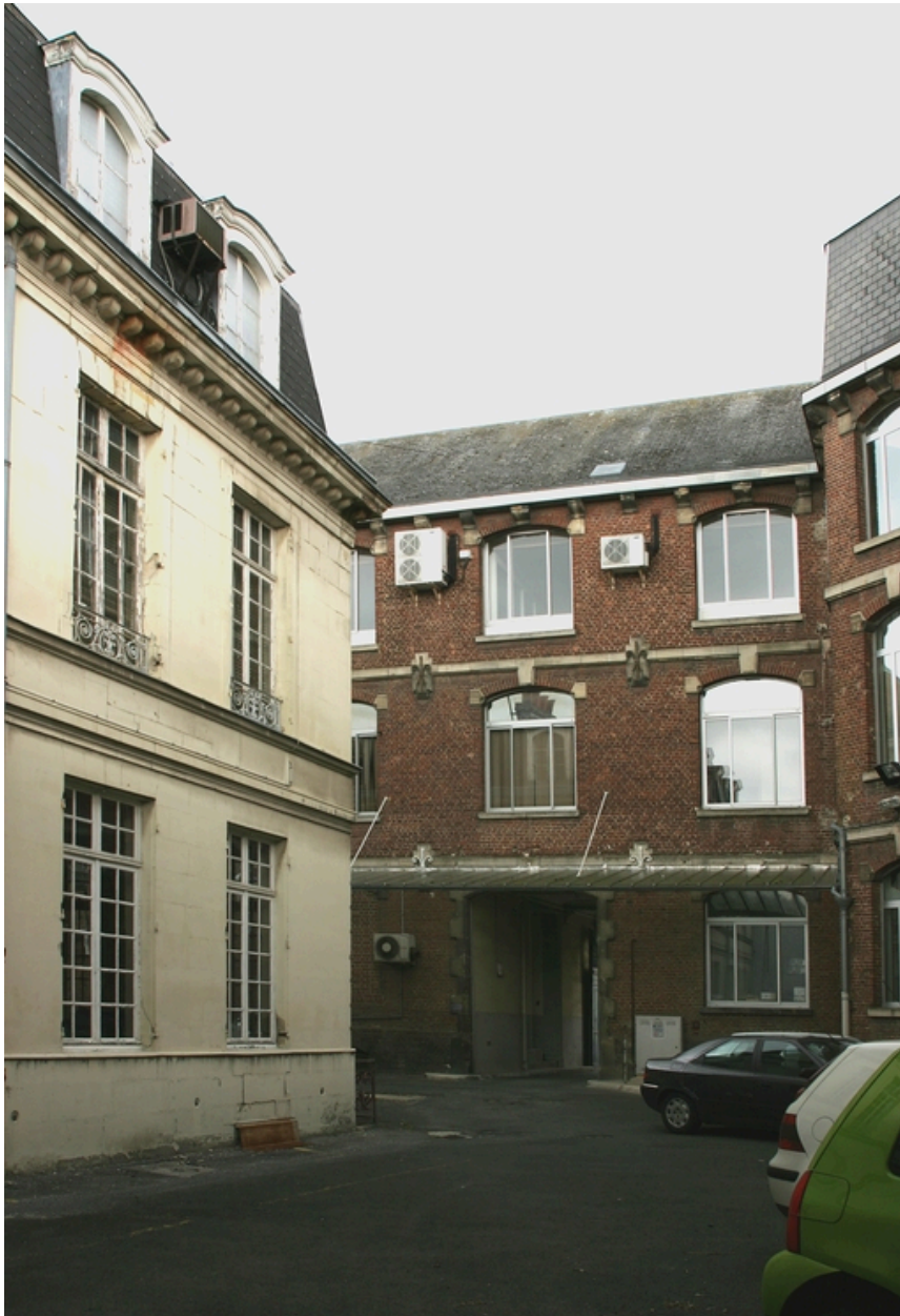
Façade postérieure de la maison de commerce (porche) et maison du directeur (à droite).
