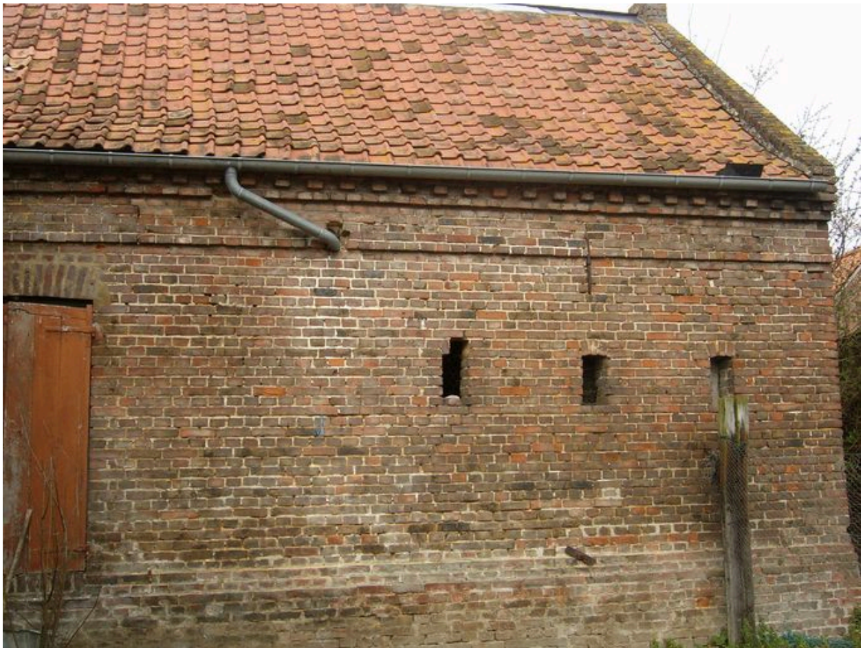
Détail de la corniche de la grange sur rue.
