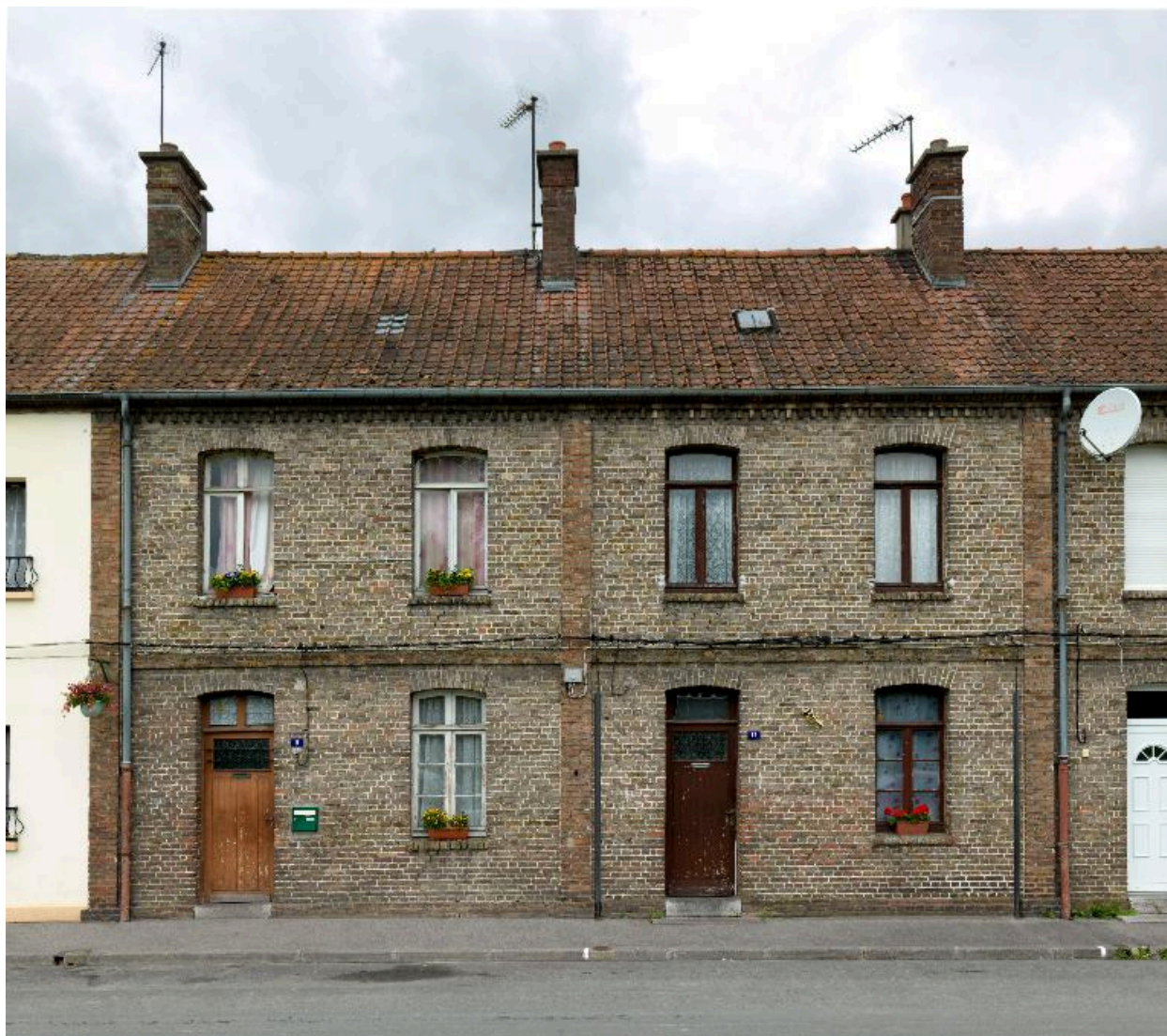
Façade sur rue des logements de cadre.
