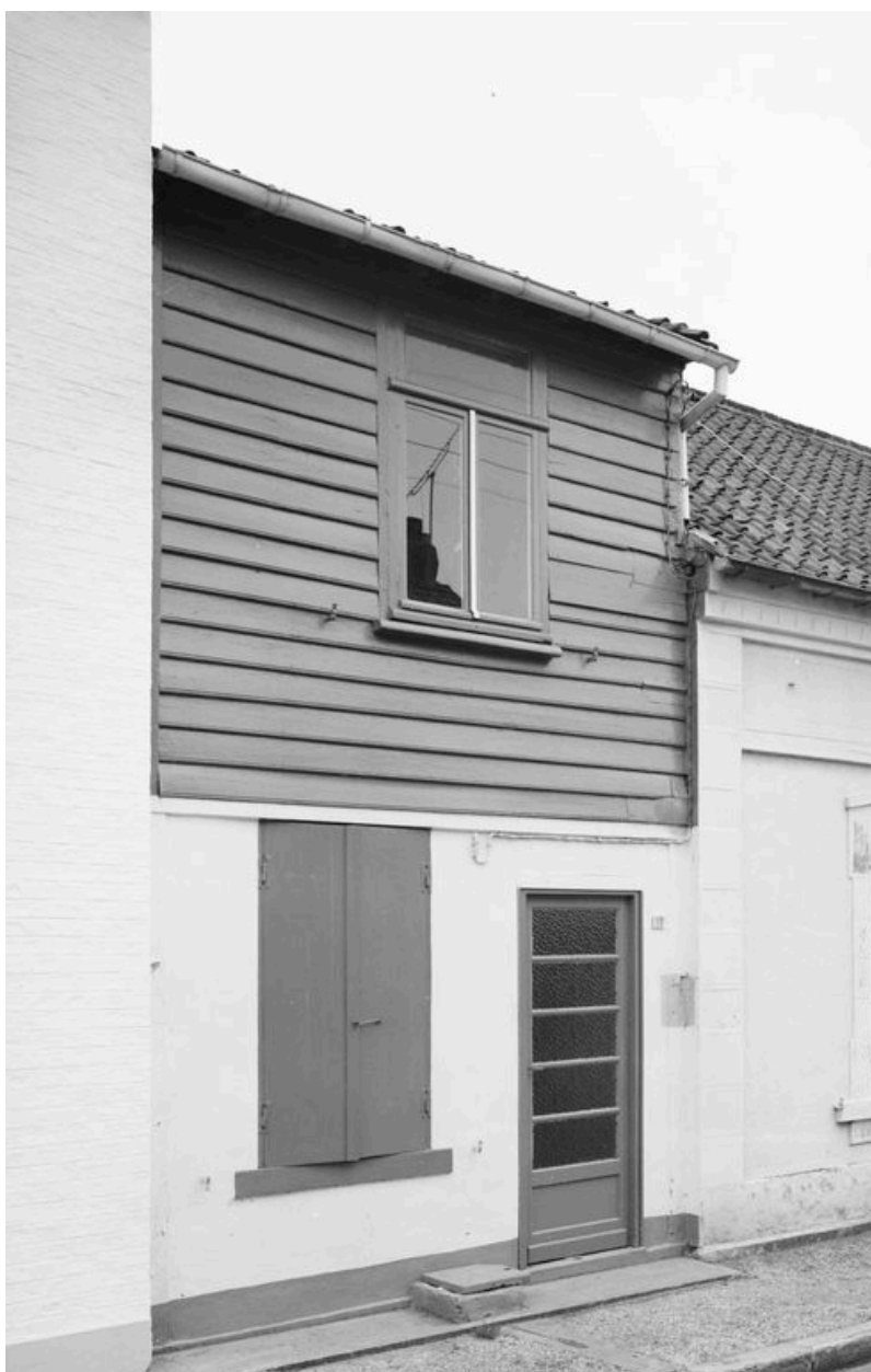
Elévation antérieure d'une maison de pêcheur.
