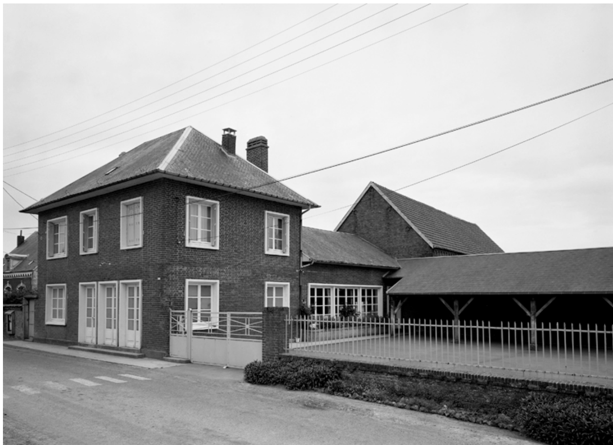
Vue d'ensemble ouest.
