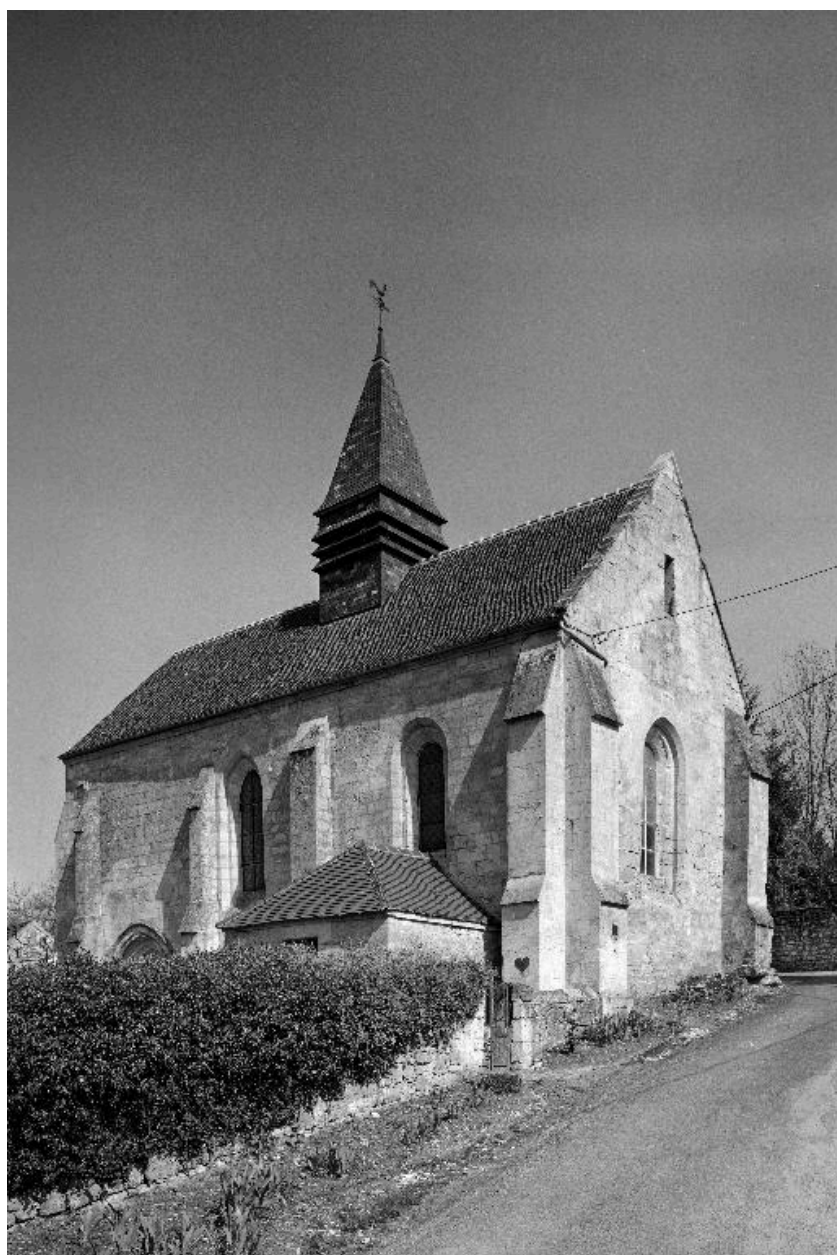
Vue générale de l'église, depuis le sud.
