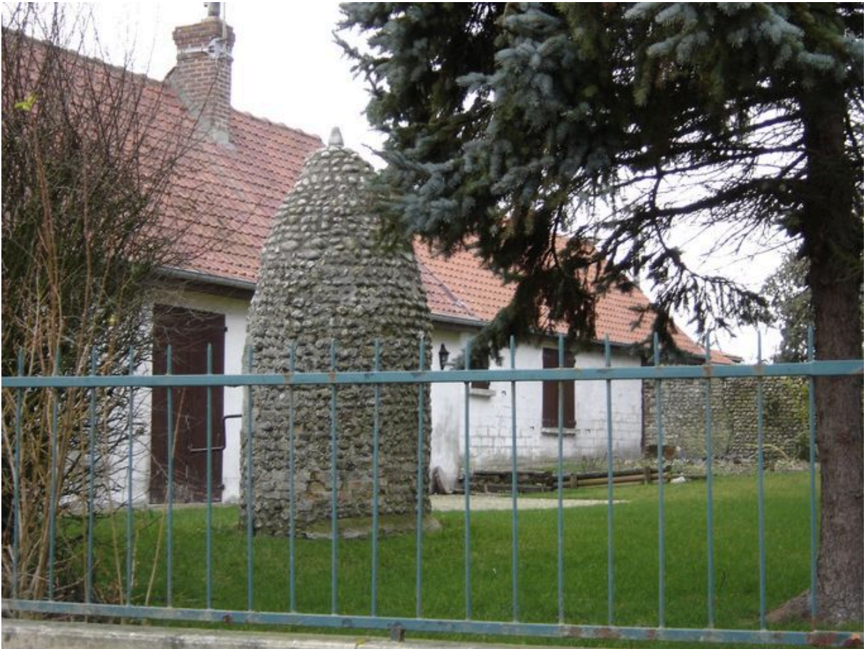
Vue détaillée du puits.
